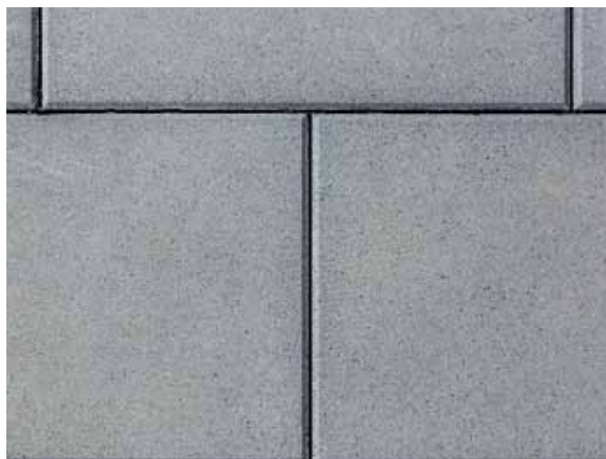
Fig. 9: Dalles en béton à bords chanfreinés
