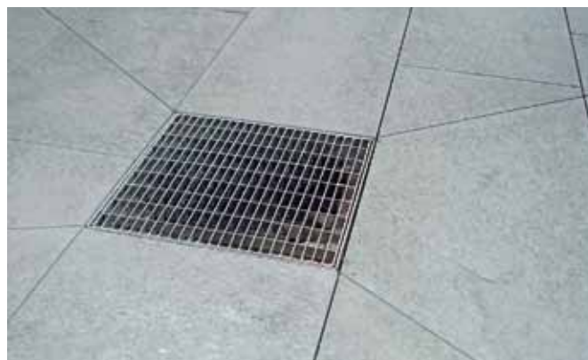
Fig. 16: Naissance d'eau pluviale: caillebotis
