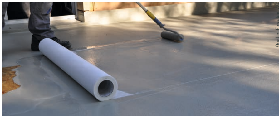
Wecryl R 230 - Flächenabdichtung mit Vlies
