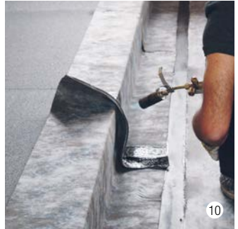
Flammfolie abflämmen und verschweißen.
