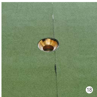
Fertig angeschlossener Dachwassereinlauf.
