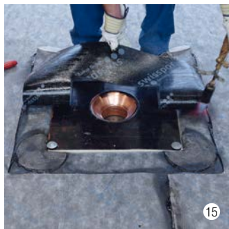
1. Lage an den Ablauf und flächig bündig anschweißen.
