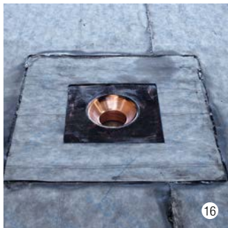
1. Lage fertig angeschlossen.
