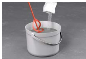
3. Katalysator (laut Mischtafel, Temperatur- und Verarbeitungszeit) bei langsam laufendem Rührwerk zugeben und 2 Min. mischen. (Kleinmengen können auch von Hand gemischt werden)
