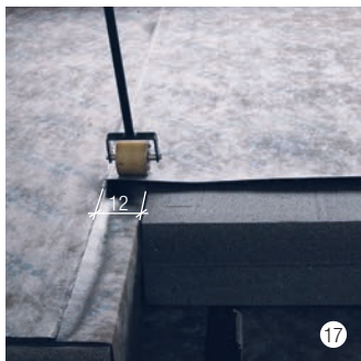
Poser la première couche d'étanchéité avec un recouvrement de 12 cm. Retirer le film sur le recouvrement et presser.
