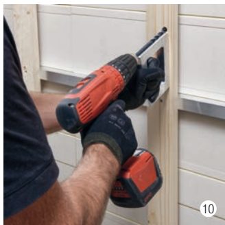
Mittels Vento Bohrlehre Untergrund 15° nach oben bohren mit Mehrzweckbohrer / Hammerbohrer je nach Untergrund, im Durchmesser von 10 mm, ausblasen.
