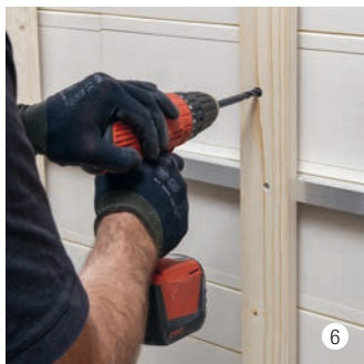
Bohren mit Mehrzweckbohrer / Hammerbohrer je nach Untergrund, im Durchmesser von 10 mm und einer min. Tiefe von 110 mm. Bohrloch reinigen mit Ausblaspumpe.
