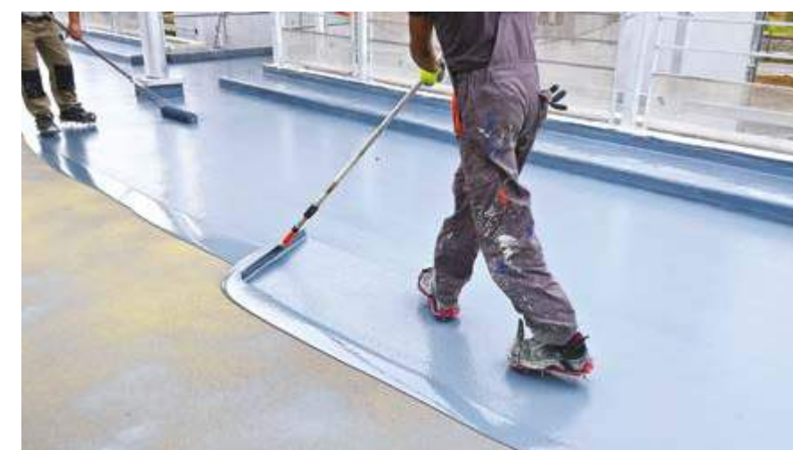
Couche de garnissage ou finition INFRAPUR FINISH 2046
