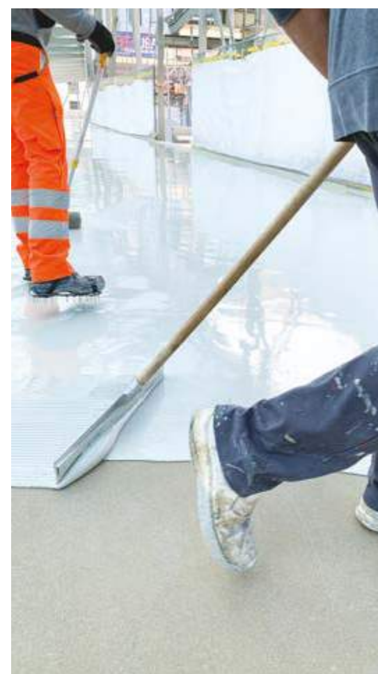
Étanchéité membrane INFRAPUR WP COATING ou GENIPUR WP COATING (pose manuelle)
