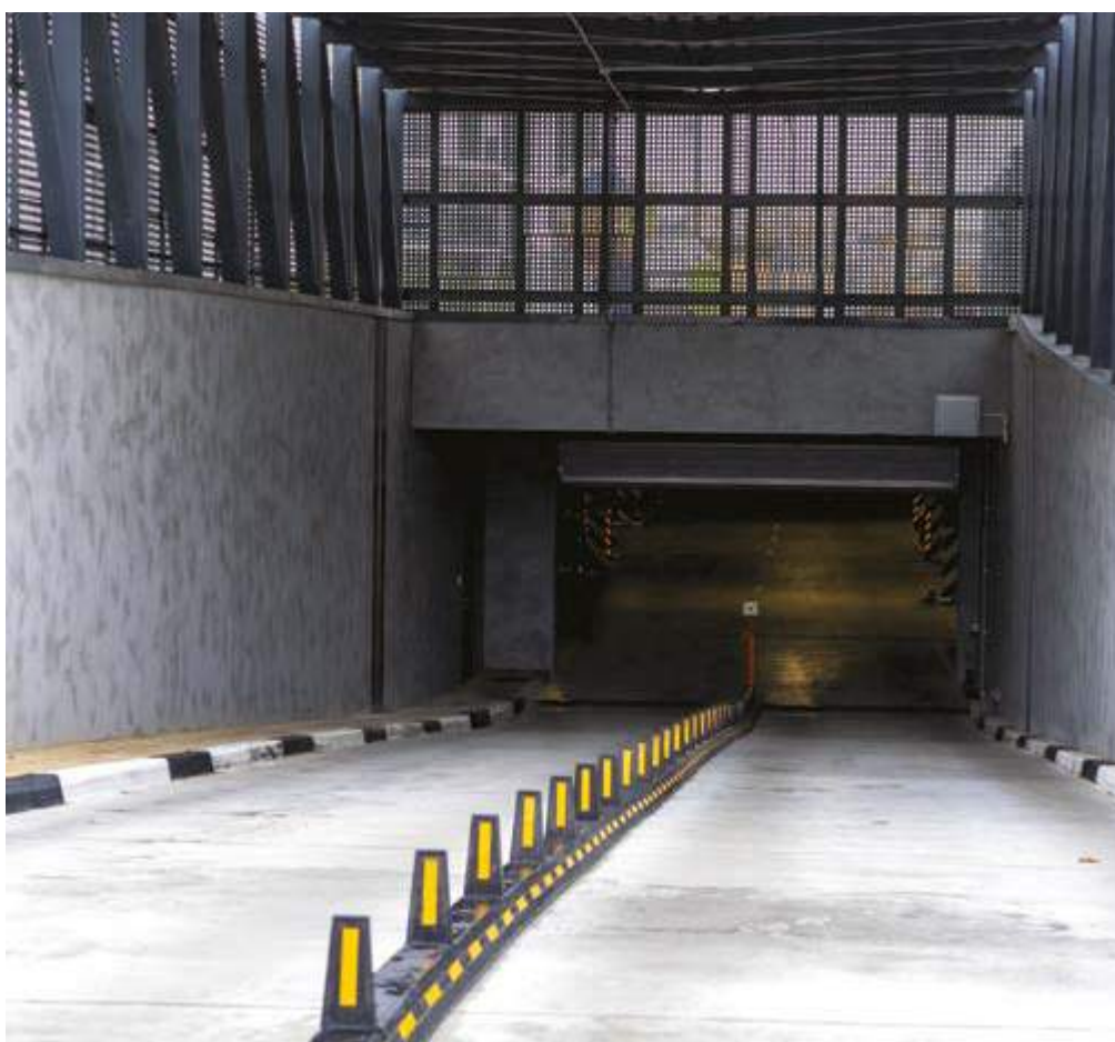
Rampes en béton lisse avec tapis à rugosité contrôlée.
