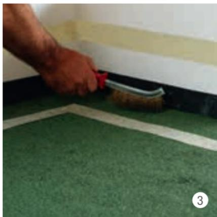
Nettoyer le lé d'étanchéité pailleté en bitume avec une brosse métallique.
