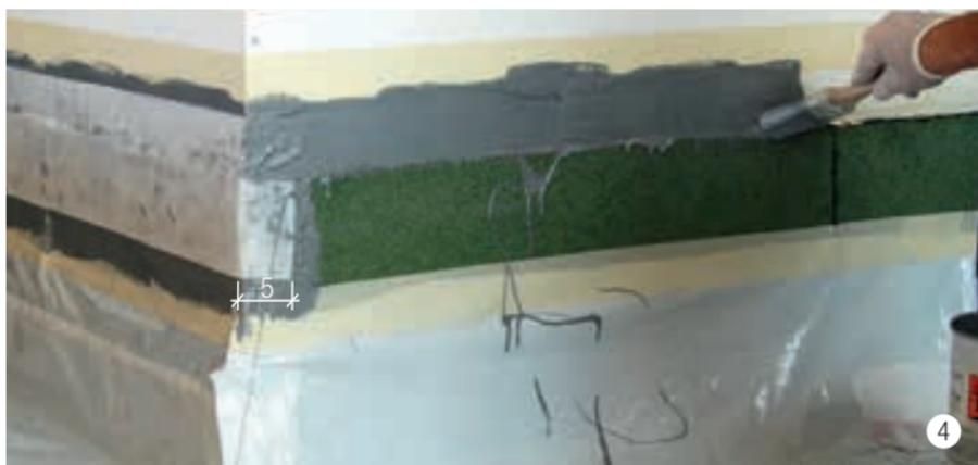
Appliquer la couche de base avec 2kg/m<sup>2</sup>. Recouvrement du voile de 5 cm.
