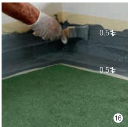
Appliquer la couche supérieure au min. de  $1 \text{ kg/m}^2$ . Les bords du voile doivent être recouverts des deux côtés de 0.5 cm.
