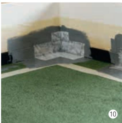
Positionner le voile des angles intérieurs et extérieurs, presser, éviter les poches d'air et les plis.
