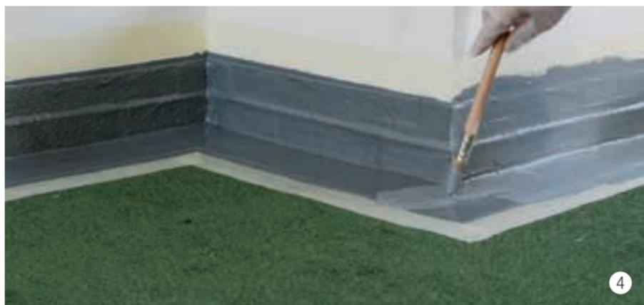
Appliquer env. 1kg/m<sup>2</sup> au moyen d'un pinceau ou d'un rouleau.
