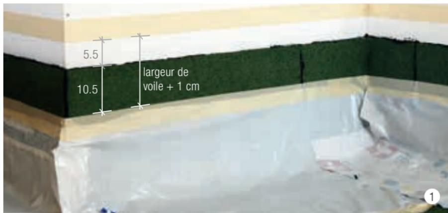
Coller le ruban adhésif sur l'étanchéité en lé bitumineux en laissant 10.5 - 11cm. Coller le ruban adhésif sur le support en laissant 5.5 - 6cm. La mesure entre les deux bandes adhésives correspond à la largeur de voile + 1 cm.
