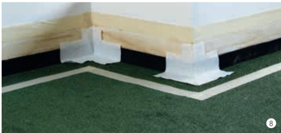
Découper les pièces dans le voile, ajuster les angles, positionner les angles préfabriqués et éventuellement les numérotéer.
