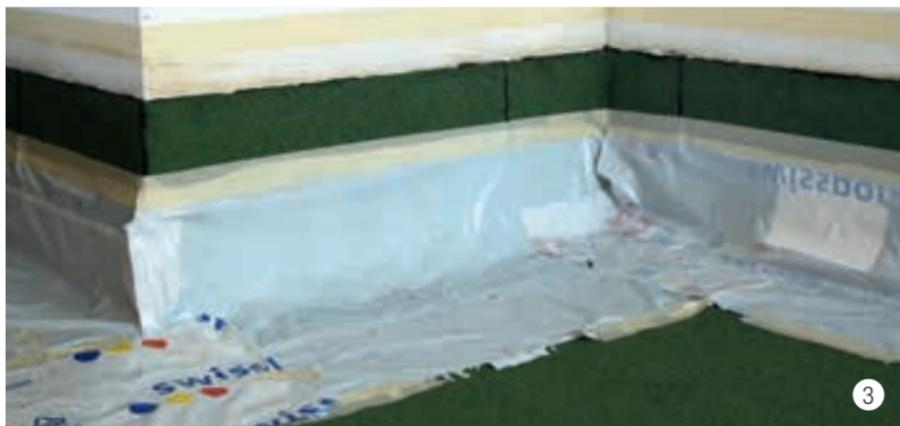
Appliquer le BIKUCOAT-Primer au pinceau ou au rouleau sur les parties à traiter, 100-300 g/m<sup>2</sup>. Temps de séchage environ 30 minutes en fonction des conditions climatiques (le Primer doit être sec et ne doit pas coller au toucher).
