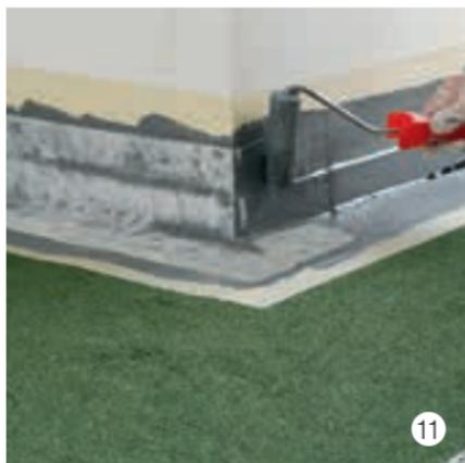
Appliquer également la base sur toutes les surfaces à étancher et sur les recouvrements du voile.
