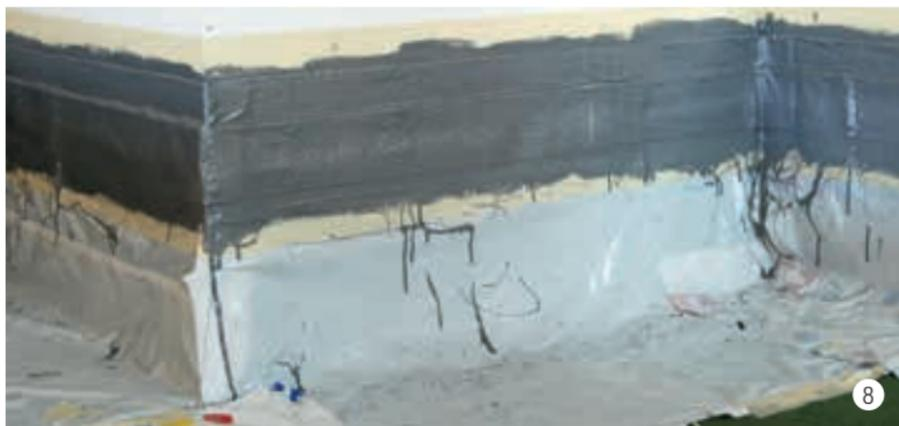
Appliquer la couche supérieure, min.  $1\text{kg/m}^2$ . La structure du voile ne doit plus être visible, la partie supérieure doit être lisse et brillante.
