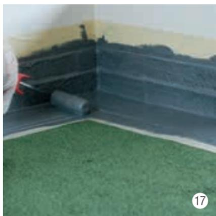
La structure du voile ne doit plus être visible, la partie supérieure doit être lisse et brillante.
