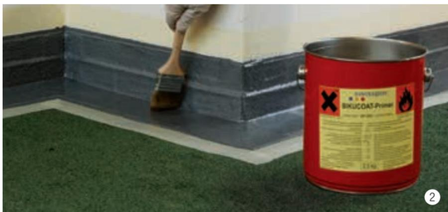
Appliquer le BIKUCOAT-Primer au pinceau ou au rouleau sur l'étanchéité liquide existante, env. 200 g/m<sup>2</sup>. Temps de séchage d'environ 30 minutes, en fonction des conditions climatiques (ne doit pas coller au toucher).
