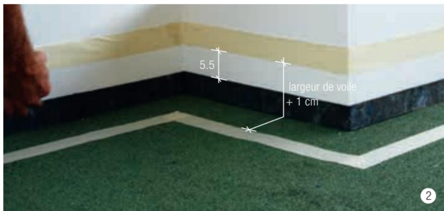
Coller le ruban adhésif sur le support à 5.5-6 cm au-dessus du relevé. La mesure entre les deux bandes de ruban adhésif correspond à la largeur de voile plus 1 cm.
