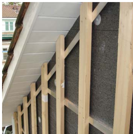
Découpes biaisées et raccord à une toiture en pente
