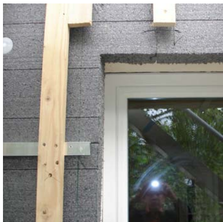
Préparation de la sous-construction avant le montage des embrasures de fenêtre
