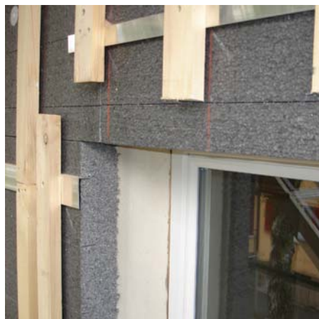
Préparation de la sous-construction avant le montage des embrasures de fenêtre
