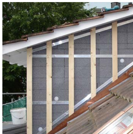
Préparation de la sous-construction avant le montage des embrasures de fenêtre
