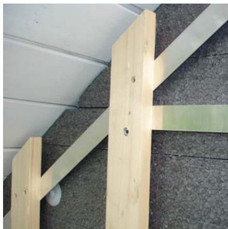
Découpes biaisées et raccord à une toiture en pente
