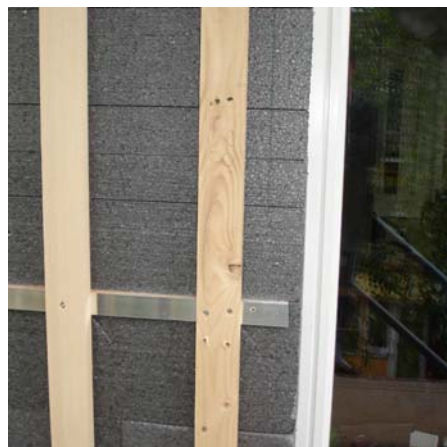
Préparation de la sous-construction avant le montage des embrasures de fenêtre
