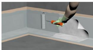
Poser les découpes de voile dans la sous-couche encore liquide et les passer immédiatement au rouleau afin de supprimer les bulles d'air. Des endroits qui restent blancs au niveau du voile indiquent que vous avez appliqué une quantité insuffisante de matériau dans l'étape précédente. En cas de chevauchement entre plusieurs découpes de voile, penser à impérativement appliquer du matériau entre les deux découpes.
