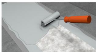
La seconde couche est appliquée « frais sur frais ». Le voile de renfort peut, immédiatement, être recouvert de Wecryl R 230 Thix/-HT. Retirer le ruban immédiatement après l'application. S'il est retiré trop tard alors que le matériau a déjà réagi, il devra éventuellement être retiré avec un cutter en apportant une attention particulière à ne pas endommager l'étanchéité fraîche.
