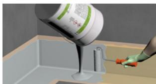
Au bout de 30 minutes seulement, appliquer la première couche (sous-couche) de Wecryl R 230 thix/-HT. Veiller à appliquer une quantité suffisante de matériau en particulier au niveau des angles, des transitions entre matériaux et des surfaces verticales (environ 1,5 kg/m<sup>2</sup>). Une quantité trop importante de matériau est automatiquement repoussée vers l'extérieur ou vers le haut lors de la pose du voile.
