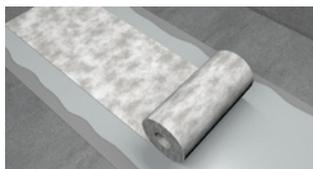
Poser le voile dans la couche fraîche et maroufler immédiatement au rouleau pour éliminer les bulles. S'il reste des zones blanches sur le voile, c'est qu'il n'y a pas assez de matière. Il est obligatoire d'appliquer suffisamment de matière entre les voiles dans les zones de recouvrement.
