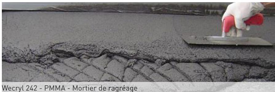
Wecryl 242 - PMMA - Mortier de ragréage
