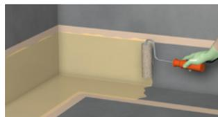
Au besoin, appliquer un enduit d'imprégnation sur la surface à étancher conformément au tableau des supports (voir p. 76-79). Appliquer l'enduit d'imprégnation au rouleau ou au pinceau.
