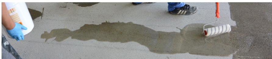
Wecryl 122 - PMMA - Enduit d'imprégnation à faible viscosité
