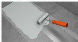
Appliquer la première couche de Wecryl R 230 thix/-HT après 30 min. d'attente. Appliquer suffisamment de matière sur les zones d'angles, les recouvrements et les surfaces verticales (consommation : env. 1.5kg/m<sup>2</sup>). Le trop plein de matière sera automatiquement éliminé lors de l'application du voile.
