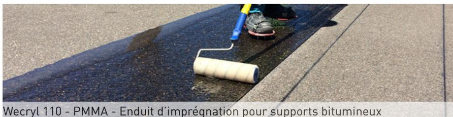
Wecryl 110 - PMMA - Enduit d'imprégnation pour supports bitumineux
