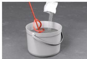
3. Ajouter le catalyseur (consulter le tableau de mélange et respecter la température et le délai de mise en œuvre) en faisant tourner le mélangeur lentement. Poursuivre le mélange pendant 2 minutes.
